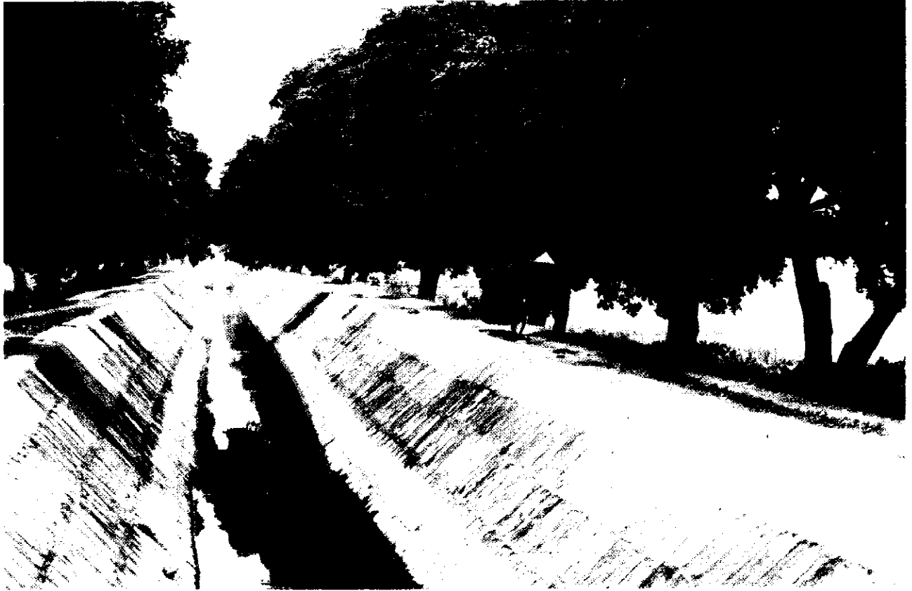
Kiên cố hóa kênh mương, công trình thủy lợi lớn của huyện Kim Bảng.
